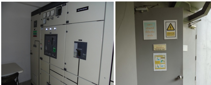
ภาพที่ 4-15 ห้องควบคุมไฟฟ้าและป้ายเตือนหน้าห้องไฟฟ้า
