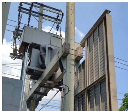
ภาพที่ 4-14 หม้อแปลงไฟฟ้า
