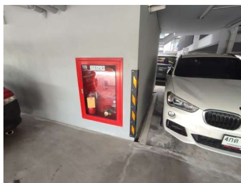
ภาพที่ 4-29 ระบบท่อเย็นพร้อมตู้เก็บอุปกรณ์ดับเพลิง
