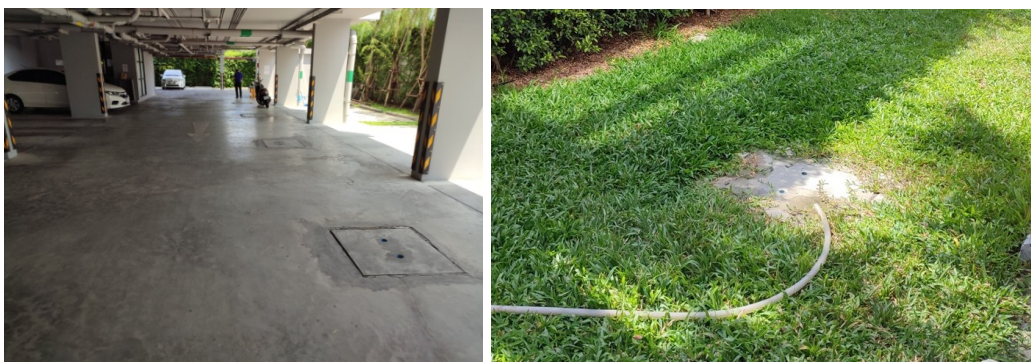
ภาพที่ 4-22 แนววางระบายน้ำและแนวท่อระบายน้ำและฝาท่อเป็นฝาคอนกรีต ไม่มีขยะอุดตัน
