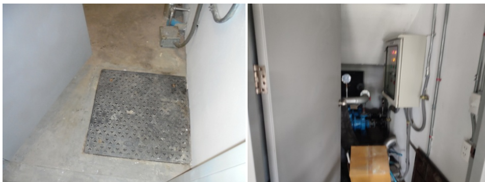
ภาพที่ 4-10 ถังเก็บน้ำใต้ดิน ฝาทรงเก็บน้ำใต้ดิน และเครื่องสูบน้ำประปา
